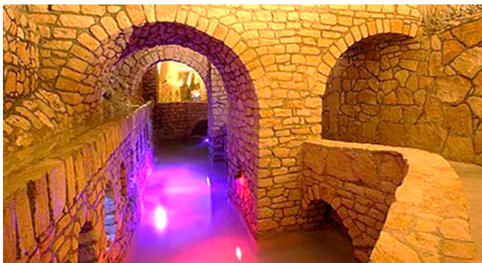
Figura 8. Fotografía de una cámara convergente de un sistema de qanat Fuente: (Pars Today, 2016)
