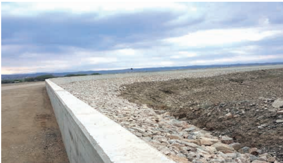
Fig. 8 Elevación de la cresta de la presa Poechos
