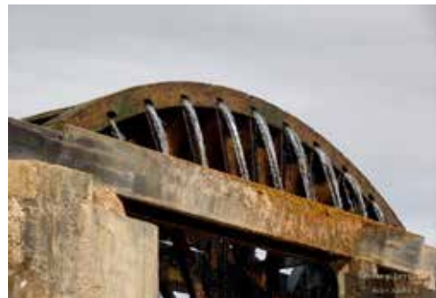
Figura 13. Fotografía del vertido superior de la aún operativa noria de Abarán, España. Abarán, cuenta con una de las norias conservadas más grandes de Europa, cerca de 12 metros de alto. Fuente: Sendas y leyendas, (2019)
